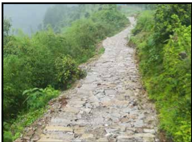
खरिखोला बजार देखि युलतेङ बाटो निर्माण
