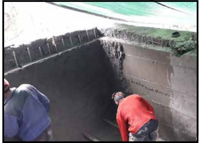
नाम्चे खानेपानी ट्याङ्की निर्माण
