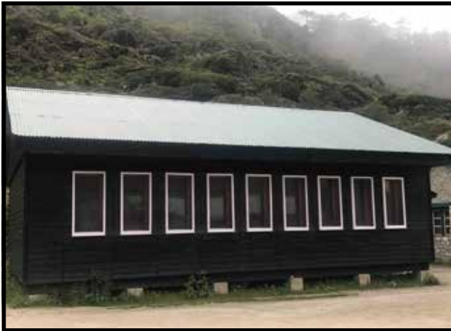
खुम्जुङ मा.वि.को भवन मर्मत सुधार
