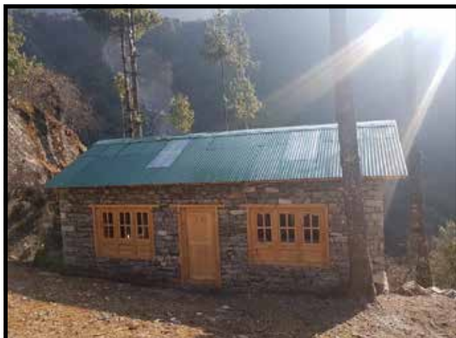
रोङदिङमा टासी उर्गेनलिङ मन्दिरको भवन निर्माण
