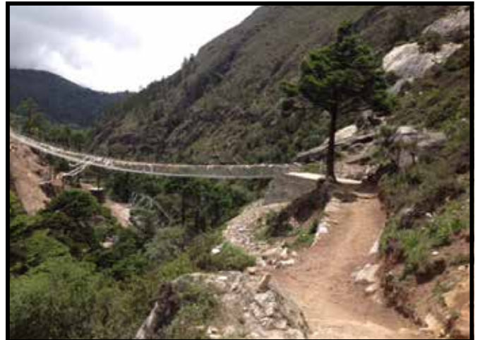
पाडबोचे पुल तथा बाटो निर्माण
