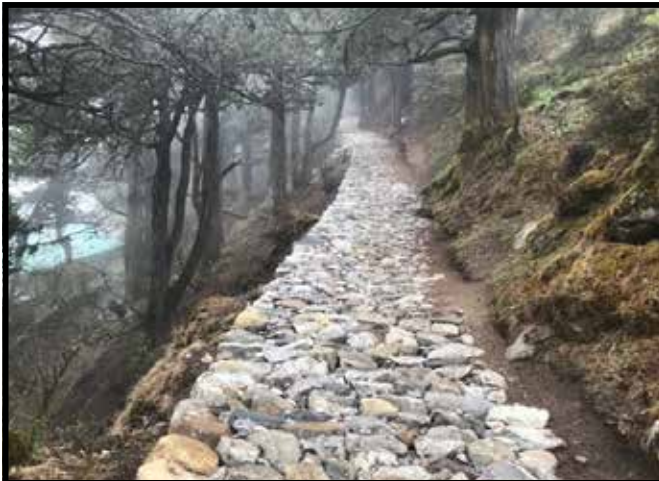
पाडबोचे बाटो निर्माण
