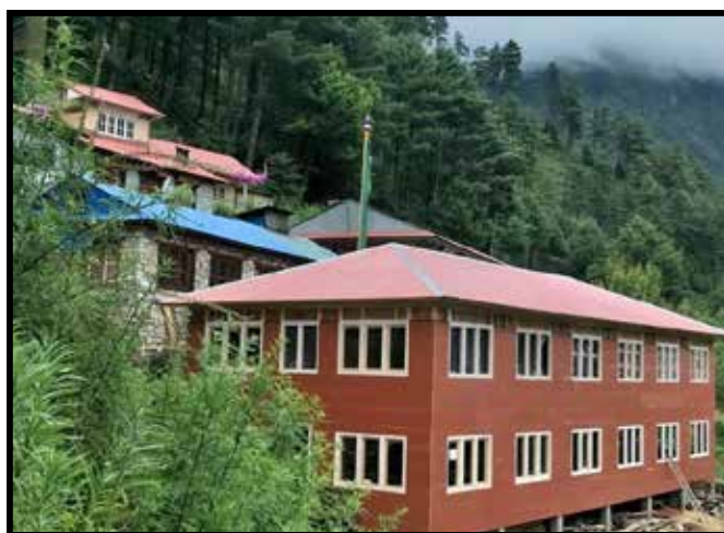
पेमा छोलिङ गुम्बाको पाहुना घर निर्माण
