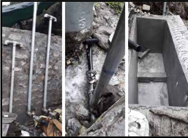
थामे खानेपानी निर्माण
