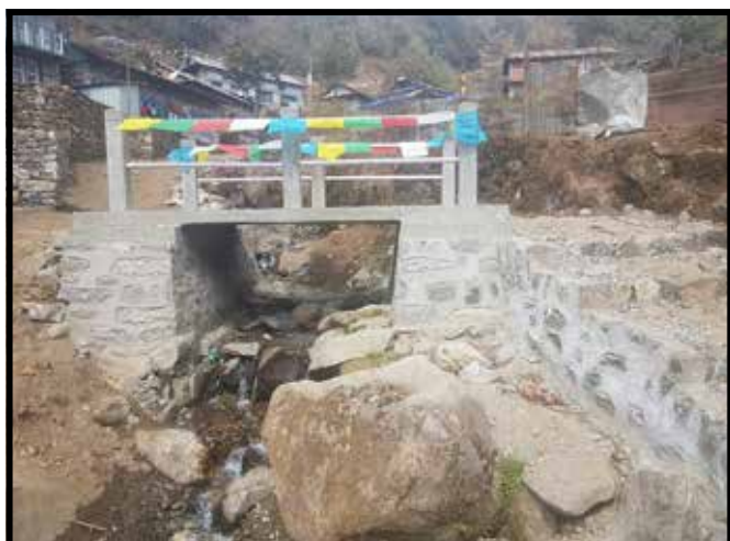
चोङमा पुल निर्माण
