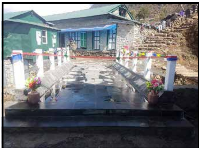
लुक्ला, तामाडटोल पुल निर्माण
