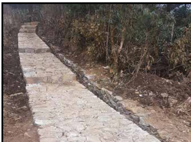
बोम बाटो निर्माण
