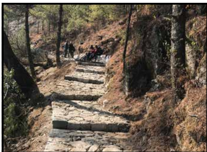
सानो गुमेला स्कूल जाने बाटो निर्माण
