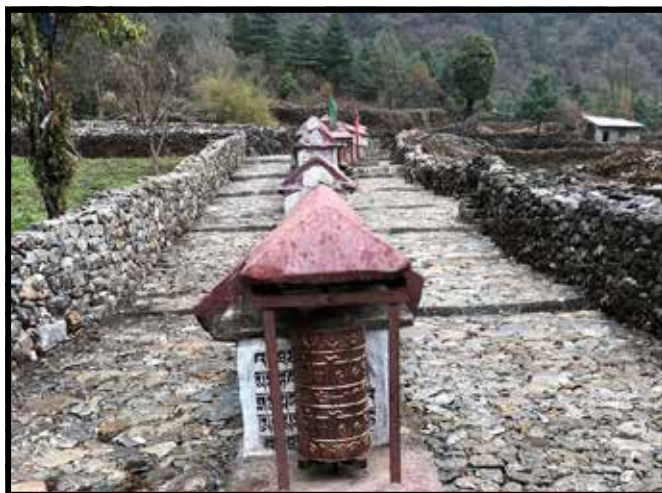
मुसे बाटो निर्माण
