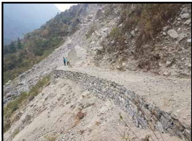
नाक्चुङ जाने बाटो निर्माण
